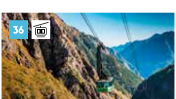
Funivia San Carlo - Robie San Carlo www.robie.ch
