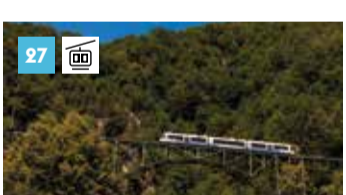
Ferrovia Vigezzina-Centovalli Muralto www.centovalli.ch
