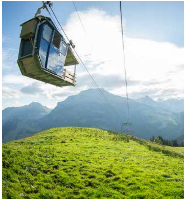
"Buiräbähni" cableway, Engelberg
