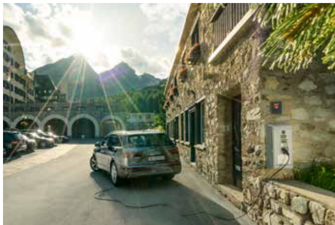
电动车充电站
